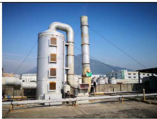
酸雾碱液逆流喷淋洗涤塔现状
